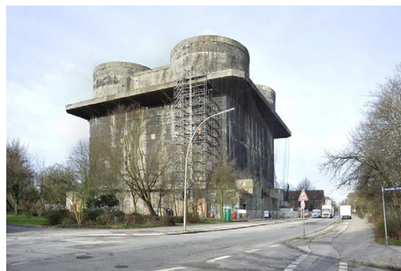
Εικ.58 Energy Bunker
