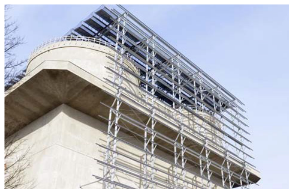
Εικ.59 Energy Bunker
