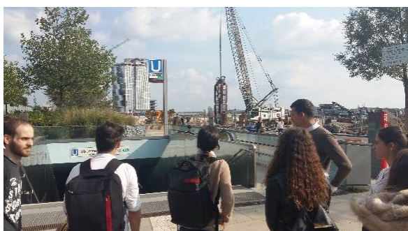
Εικ.11 Σταθμός μετρό που κατασκευάζεται.
