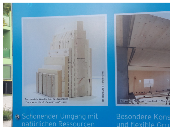
Εικ.33 Λεπτομέρεια του τοίχου από συμπαγή ξυλεία
