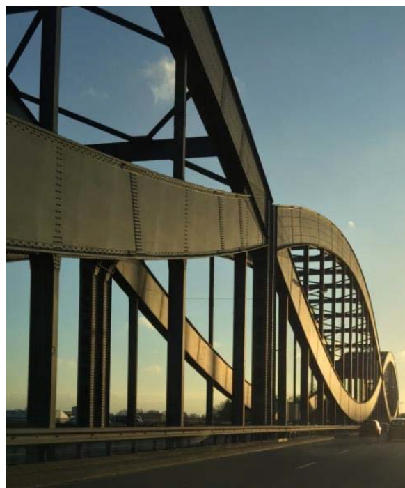
Εικ.52 Hamburg Elbe Bridges
