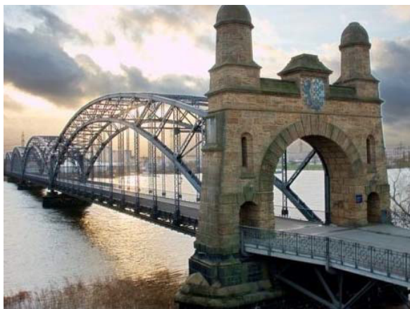
Εικ.54 Hamburg Elbe Bridges
