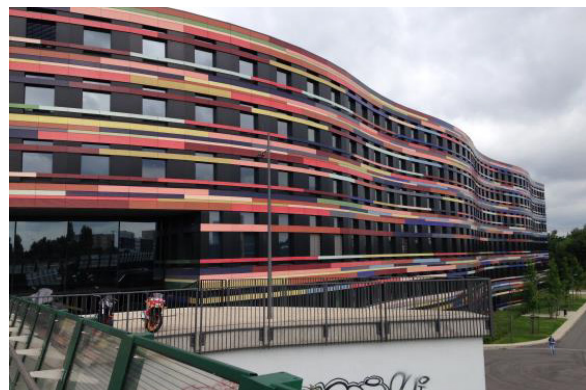
Εικ.48 Τμήμα της εξωτερικής πρόσοψης του Υπουργείου Αστικής Ανάπτυξης και Στέγασης. Η επένδυση έχει γίνει με ειδικά χρωματιστά κεραμικά τεμάχια.
