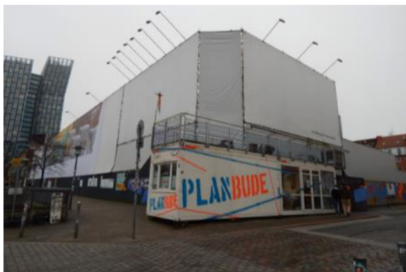
Εικ.34 To container
