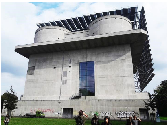
Εικ.37 Energy Bunker
