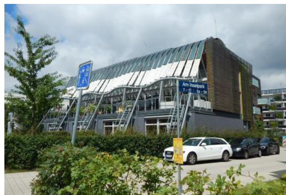
Εικ.5 Παθητικό κτήριο κατοικιών στο Wilhelmsburger Inselpark.
