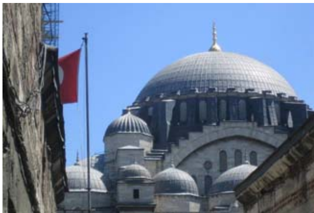
Εικ.26: Εξωτερική άποψη του Σουλεϊμανιγιέ.
