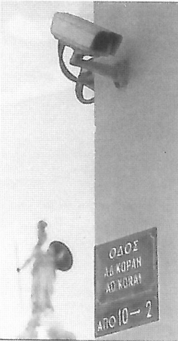
9. Κάμερες υπό το βλέμμα της Παλλάδος. Ιδιωτική ασφάλεια τραπεζών, κτηρίων γραφείων και άλλων ιδιωτικών χώρων. Η κατάχρηση της «κάμερας» οδηγεί σε χρήση της και για την παρακολούθηση εργαζομένων στον χώρο και την ώρα εργασίας, φυσικά στην πόλη πέρα από την μεμονωμένη ιδιωτική χρήση, χρησιμοποιείται και από το κράτος σε δίκτυο, για συνολική παρακολούθηση της δημόσιας ζωής και όχι μόνο σε στιγμές έντασης. Πηγή: Ελευθεροτυπία 2.6.2002.
