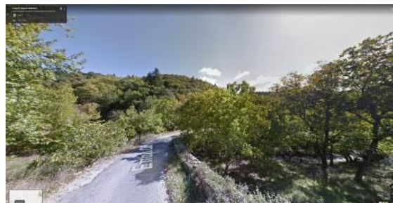
Σ2 γέφυρα – διασταύρωση με μονοπάτι
