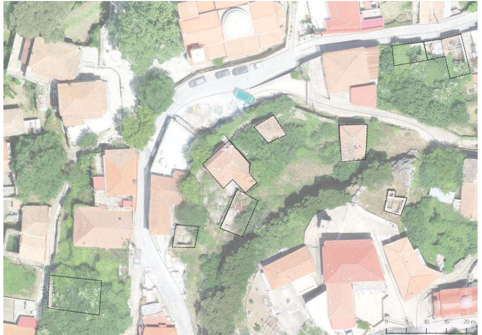
Εικ. 1.62 Συγκεντρώσεις ερειπίων στον κεντρικό πυρήνα του οικισμού Πηγή: ερευνητική ομάδα
