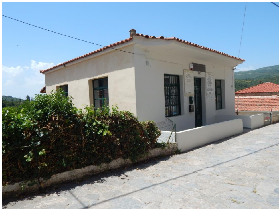
Σχ. 57. Μη παραδοσιακό κεραμοσκεπές διώροφο κτήριο, κοινοτικής χρή- σης, σε καλή κατάσταση
