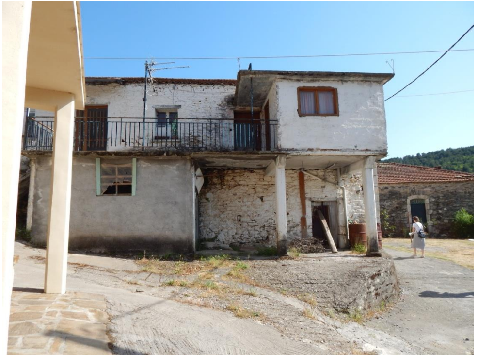
Σχ. 55. Παραδοσιακή, αλλοιωμένη, κεραμοσκεπής διώροφη κατοικία, με πλακοσκεπές τμήμα, σε μέτρια κατάσταση
