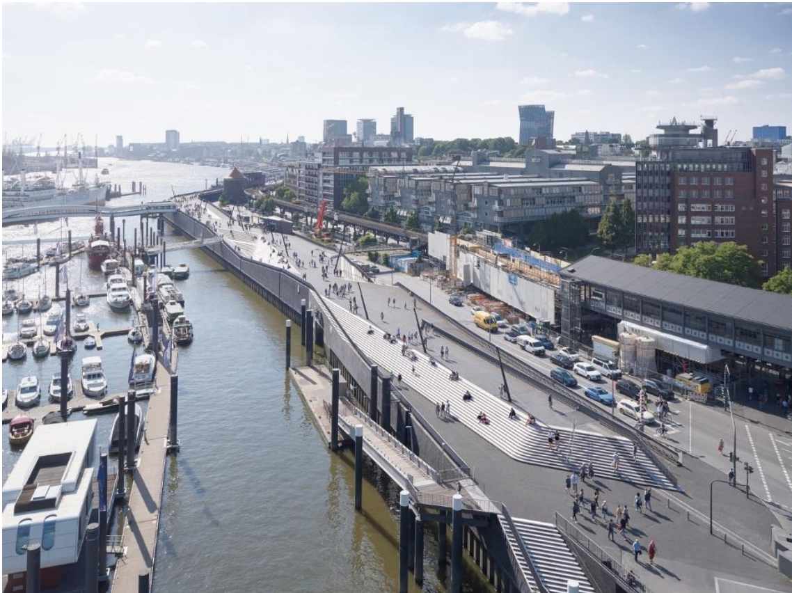
Σχ. Γ5.40. Άποψη παρόχθιου φράγματος ποταμού Έλβα (πηγή: dezeen, archdaily, Wikipedia).
