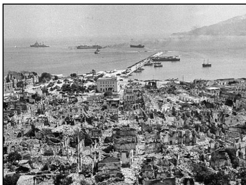
Σχ. Β2.6. Ληξούρι, Κεφαλονιά μετά το σεισμό του 1953
