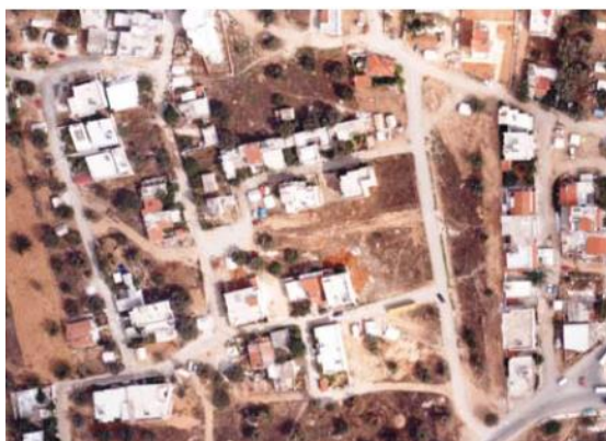
Εικόνα 4.2.13. Αεροφωτογραφία Ο.Τ. 1374 πριν το σεισμό. Πηγή: www.dae.gr/css/default/templates/project/article.php?lng=1&cat=26&doc=309
