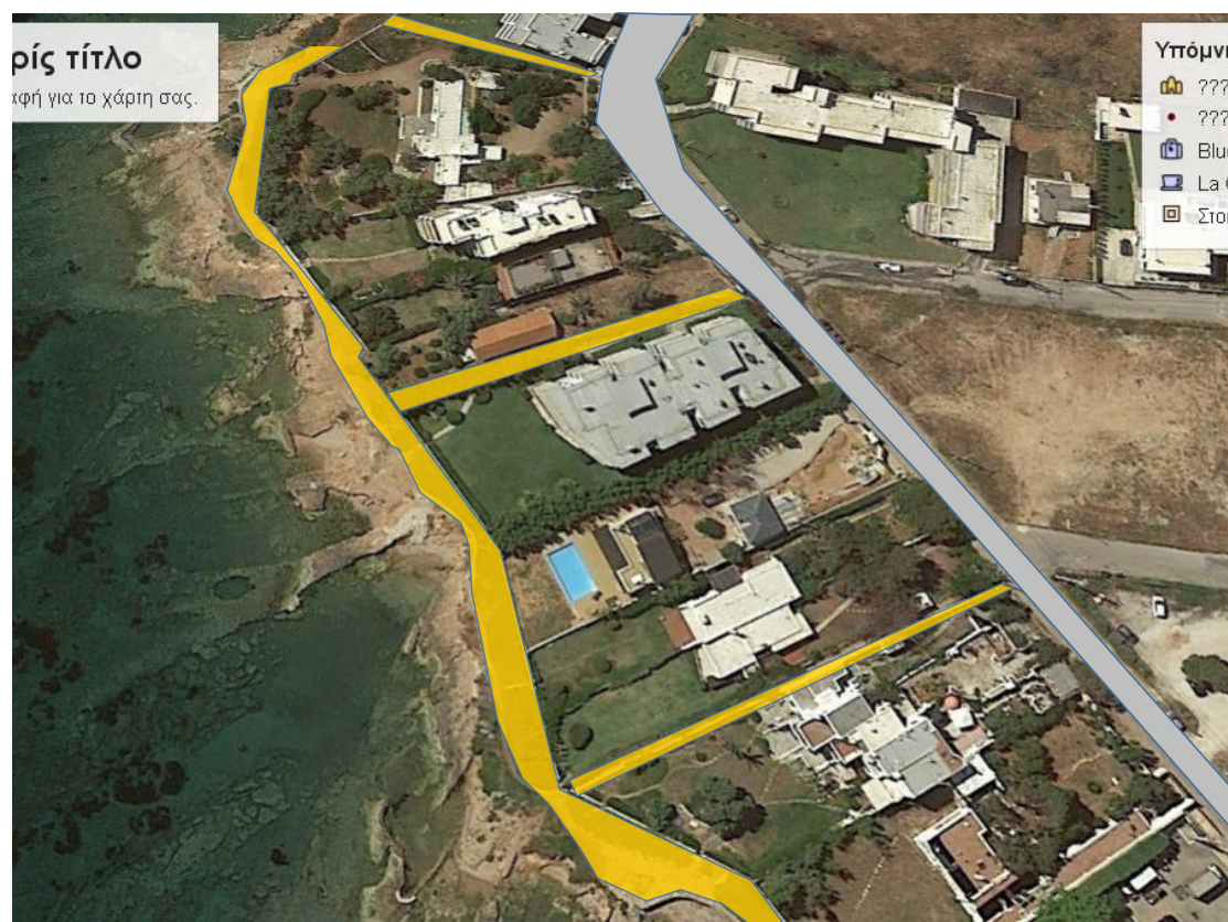
Εικ. 2,3: Μετάθεση παράκτιου δρόμου (κίτρινο χρώμα) σε κοντινή απόσταση από το «φρύδι» της ακτογραμμής έτσι ώστε να εξυπηρετεί το παράκτιο μονοπάτι (πράσινο χρώμα) μέσω κάθετων συνδέσεων πλάτους 2μ που θα μπορούσαν να δημιουργηθούν στα όρια ανάμεσα στις ιδιοκτησίες.
